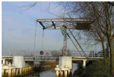
De ijzeren ophaalbrug over de IJzer op het gehucht Elzendamme.
