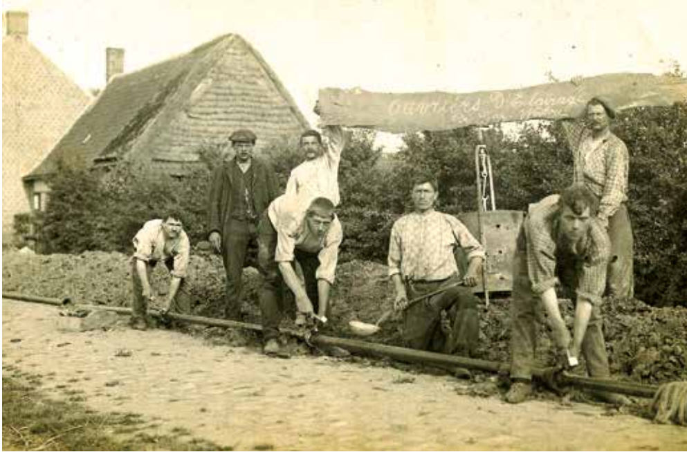
Aanleg gasleiding voor straatverlichting
