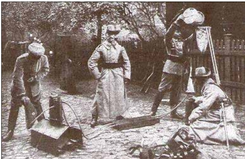
Draagbare Henneberg-Hartmann drinkwaterbereider in actie.
